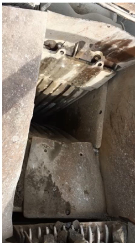
Figura 1.2: Britador primário da Pedreira Santa Cornélia
